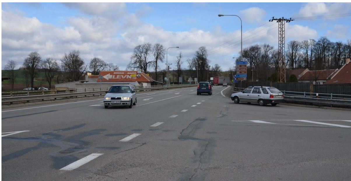
Obrázek 2 Pohled na stávající odsazenou křižovatku ze směru od Bučovic směrem do Holubic
