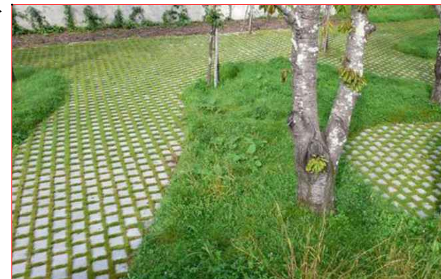
Možné řešení vsakovací dlažby v místech parkovacích stání
